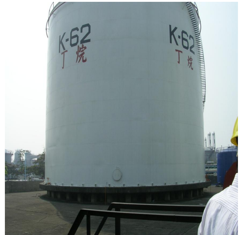
儲槽預防工程設施-懸空(2)
