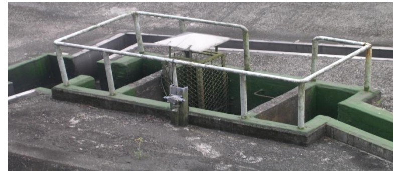
水溝柵欄收集工程
