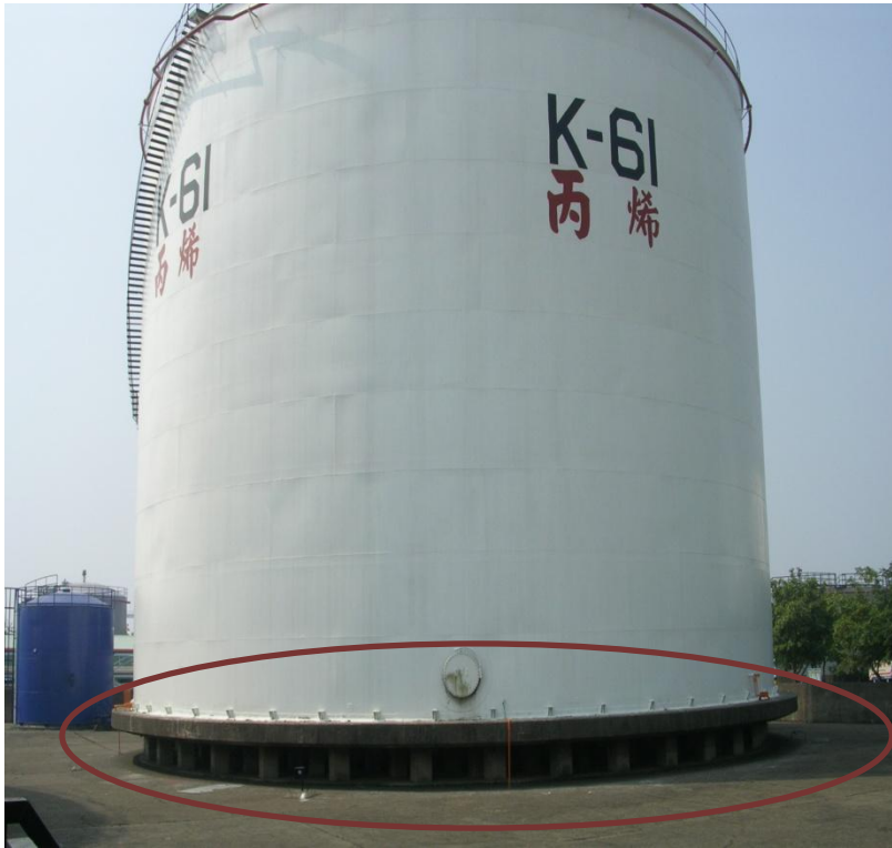
儲槽預防工程設施-懸空(1)
